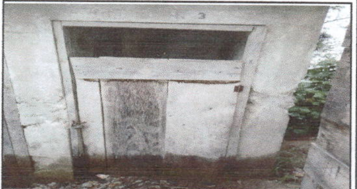
Foto 4: Reparación de Puertas para baños
