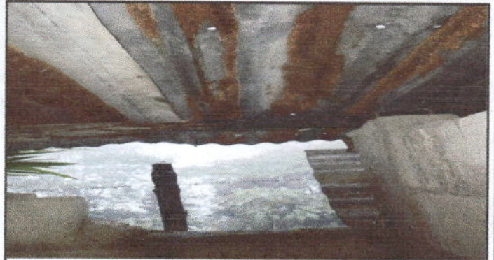
Foto 2: Reparacion de Techo para baños
