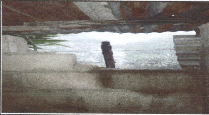
Foto 1: Reparacion de Pared de baños
