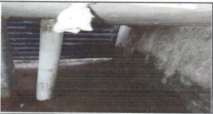
Foto 5: Reparación de Tubos para baños
