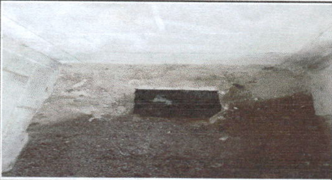
Foto 3: Reposicion de Sanitarios
