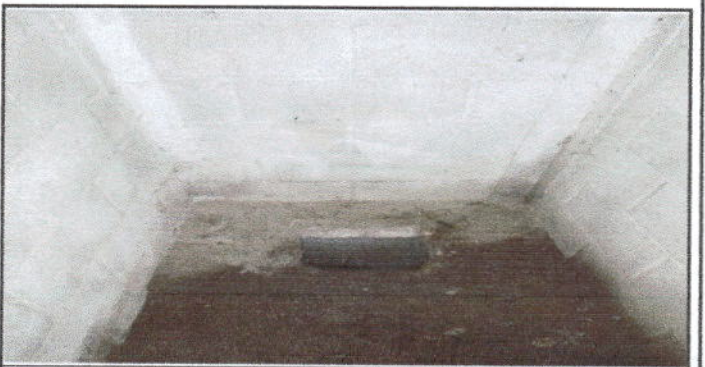
Foto 6: Reparacion de piso para baño
